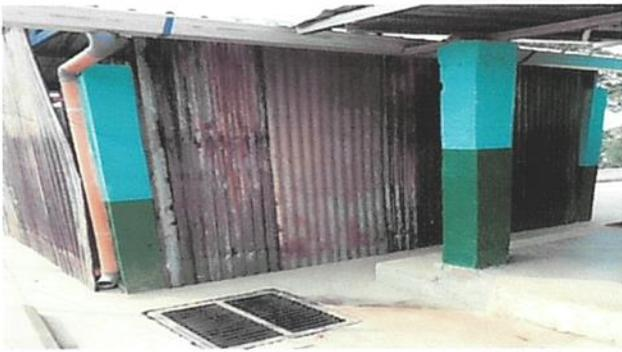
Foto 21: Sustitución de lamina por block en area de cocina
