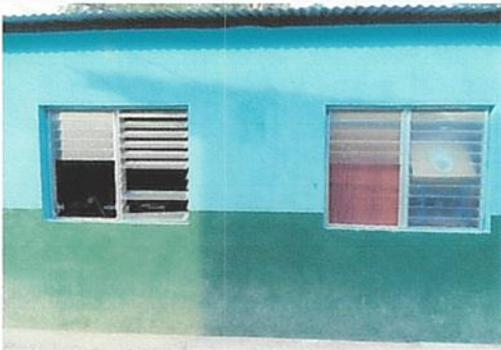
Foto 5: Sustitución de balcones de metal
