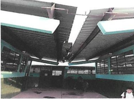
Foto 7: Sustitución de canal de metal
